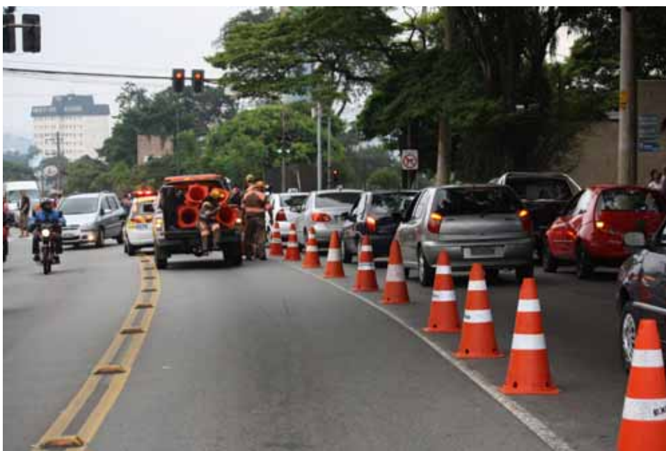
Foto 5 – Montagem de Faixa adicional reversível na Av. Giovanni Gronchi x R. Francisco Tomas de Carvalho
